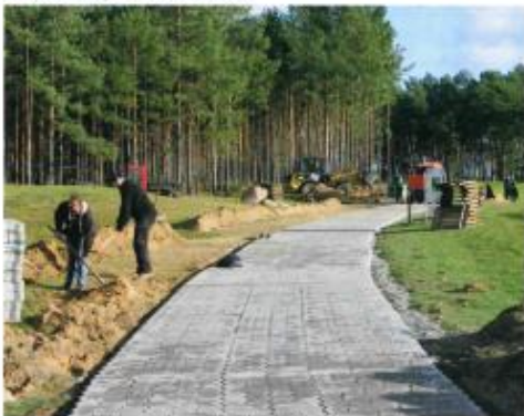
• Der gepflasterte Weg zwischen der B6, C4 und der B5 ist fertiggestellt
